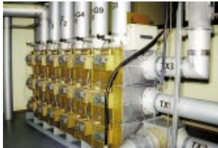
Die Schaltmatrix für die Kurzwellensender; rechts seitlich die Sendereingänge, oben die Ausgänge zu Baluns bzw. Antennen
